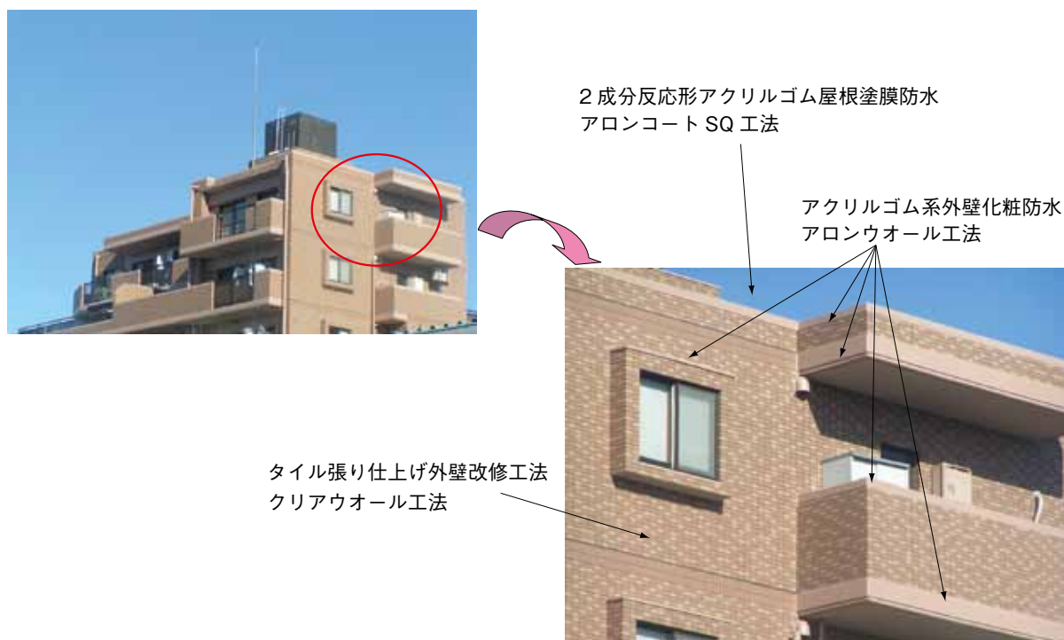
写真1 マンションのトータル改修（屋根・外壁）施工例
