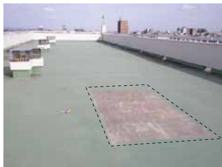
写真3 アロンコート SQ 塗膜の採取状況
