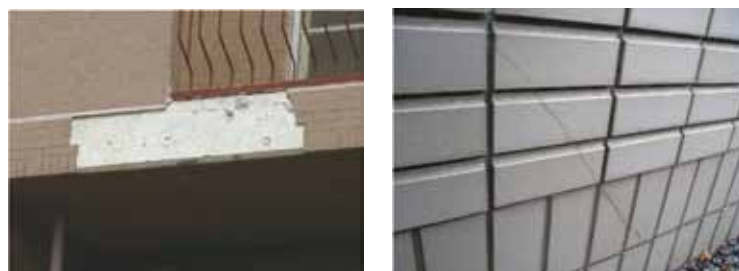
写真5 外壁タイル仕上げに発生する剥落とひび割れ
