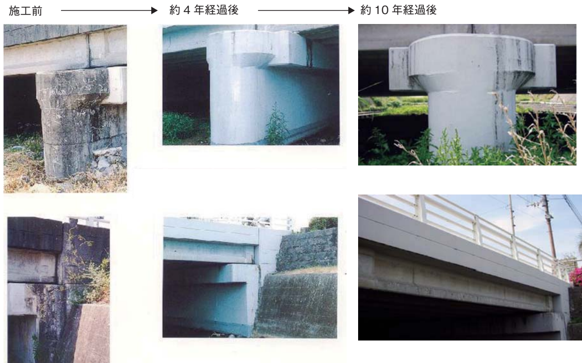
写真 20 アルカリ骨材反応による劣化構造物の経年調査結果（約 10 年）
