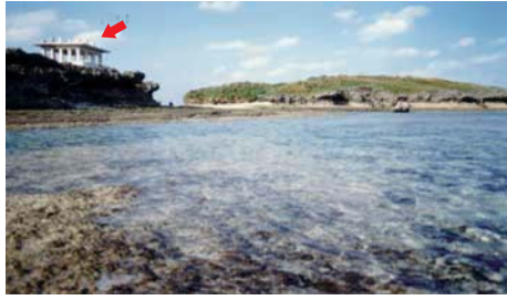
写真7 RC 実験構造物外観
