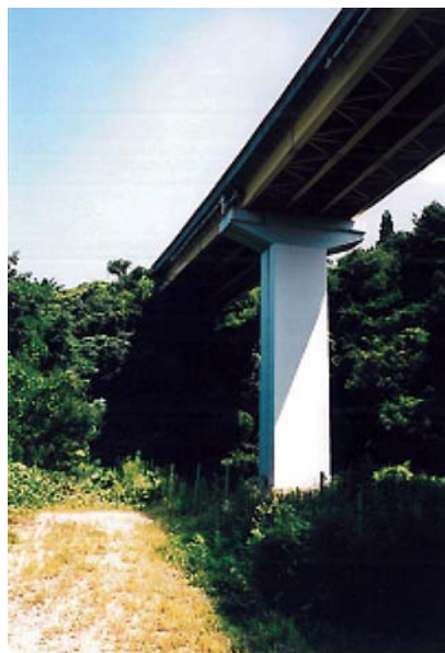
写真 13 ASR の発生した橋脚にアクリルゴム系保護塗膜の上塗材として高反射塗料を施工した事例
