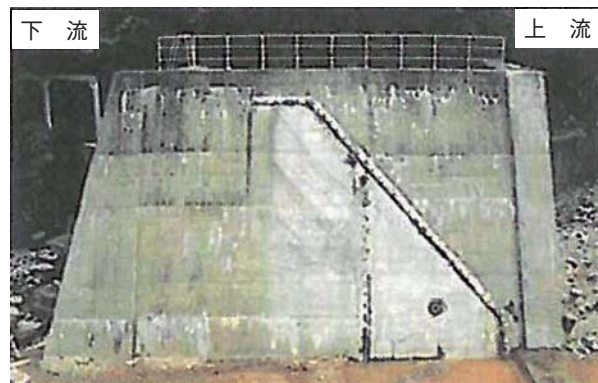
(b) ゴム堰側の表面劣化状況(右岸)
