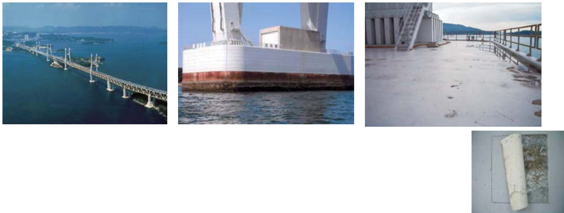
写真 19 本四連絡橋 17 年後の外観および塗膜採取状況
