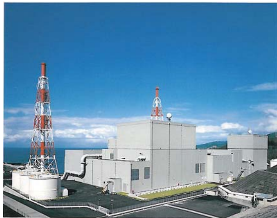
島根原子力発電所
