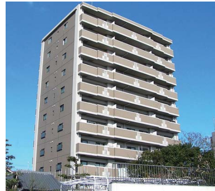
施工例：シャトー中村
