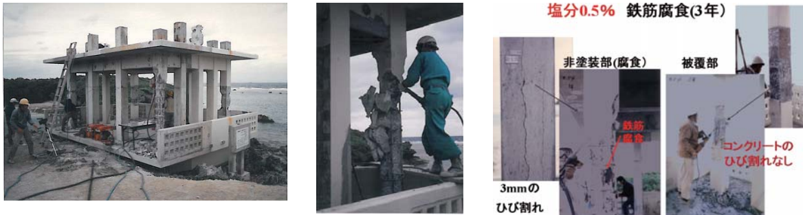
アロンウオール塗膜がコンクリートの落下を押さえている状況
