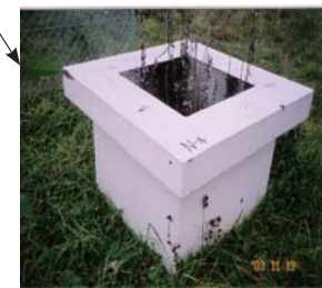
アクリルゴム塗装 異常なし
