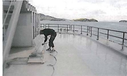
防水層の吹付
