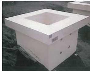
アクリルゴム塗装 異常なし
