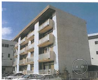
A：アロンウオール被覆面（東面1階壁部） B：アロンウオール非被覆面（東面1階壁部）
