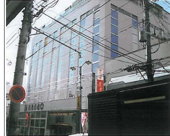
タイル外壁をアロンウォールピンネット工法で施工した物件。異常なし。
