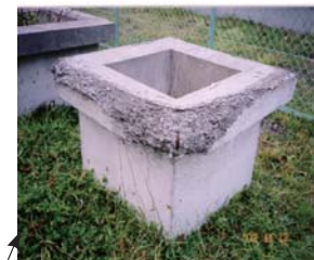
非塗装 コンクリートつば部が凍害で崩壊
