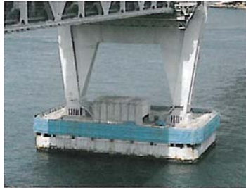
岸場の架設完了
