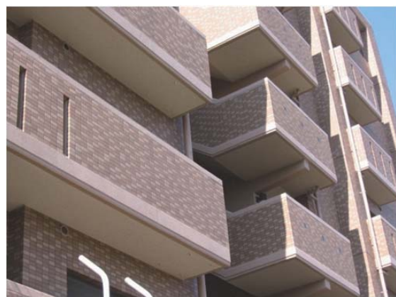
写真 29 施工後5年7か月経過のベランダ外壁 ・雨掛かりのベランダ外壁 ・雨筋汚れなく良好
