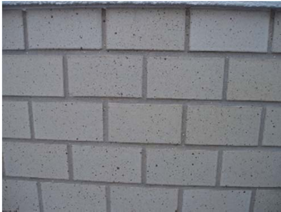
写真3 洗浄後のタイルと目地状況
