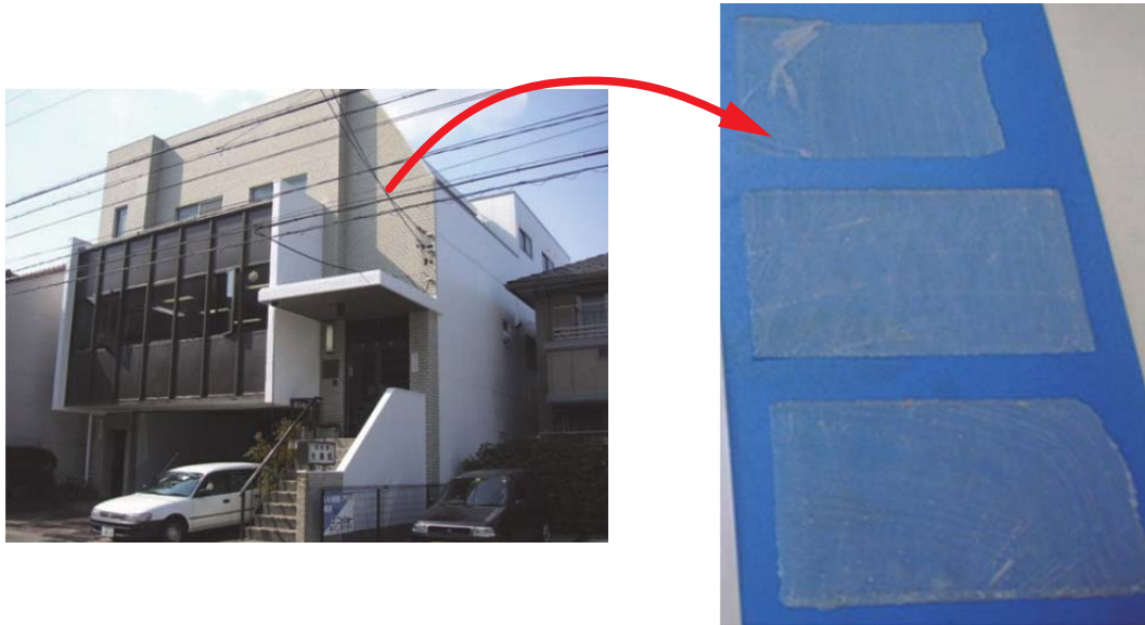
写真14 塗膜採取箇所（南東面より採取）と採取した塗膜
