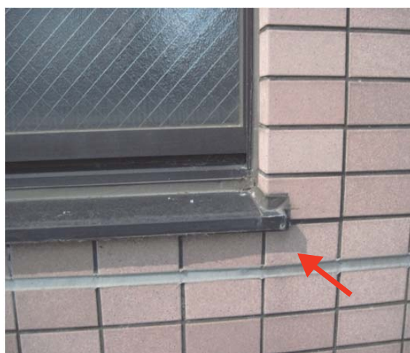
写真 24 改修後 3 年 10 か月経過後のサッシ下の状況 ・雨筋汚れなし
