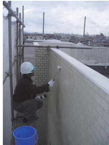
写真4 CP-100 [下塗用] 塗布 (気温 7℃)
