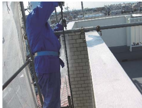
写真2 高圧水洗による汚水と洗剤の除去
