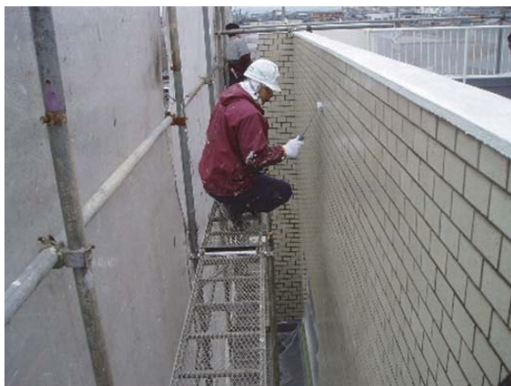
写真7 CT-300 [上塗用] 塗布 (気温 6℃)
