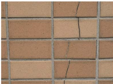
写真 32 タイルの割れ
