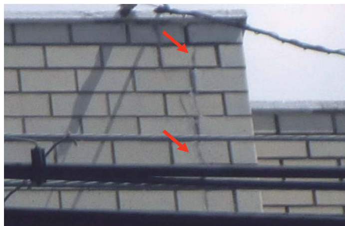
写真13 タイル割れ部の補修箇所 ・ひび割れの進展や塗膜の破断は認められなかった
