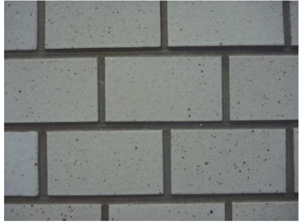
写真10 タイルと目地状況
