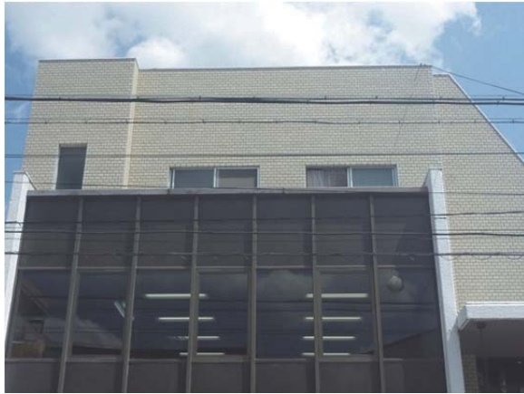
写真9 クリアウオール施工6年後の外観
