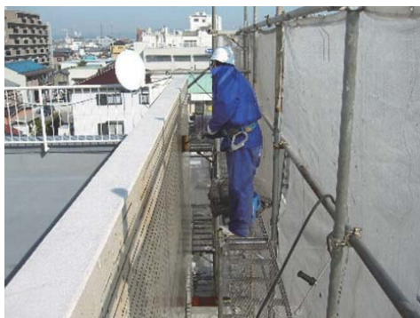
写真1 洗剤を用いた洗浄
