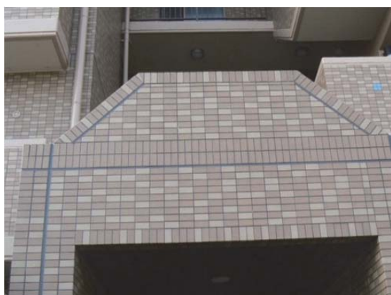
写真 27 施工直後のエントランス上部
