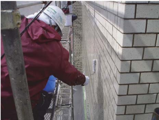
写真5 CS-200 [中塗用] 塗布 (気温 10℃)
