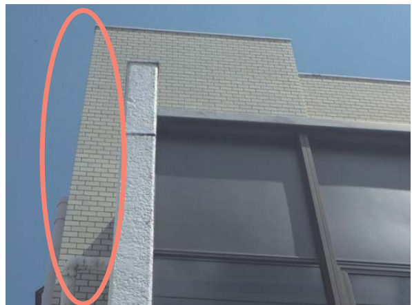
写真12 施工6年後の状況 ・コーナー部に雨筋汚れの発生なく良好
