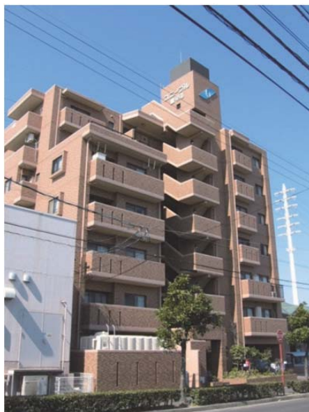
写真 26 クリアウオール施工直後の外観（2007年12月）
