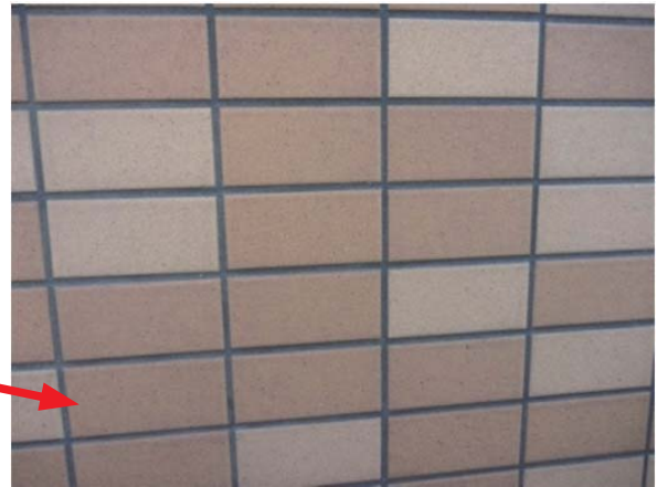
写真 31 ベランダ外壁の拡大 ・雨筋汚れなく良好
