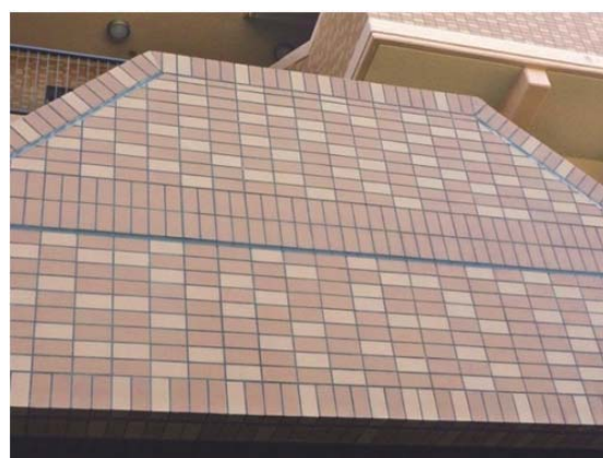
写真 28 施工後のエントランス上部 （5年7か月経過後） ・雨筋汚れなく良好
