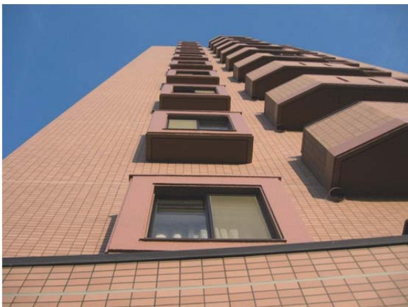
写真 21 改修後 3 年 10 か月経過後の外観（その 1）
