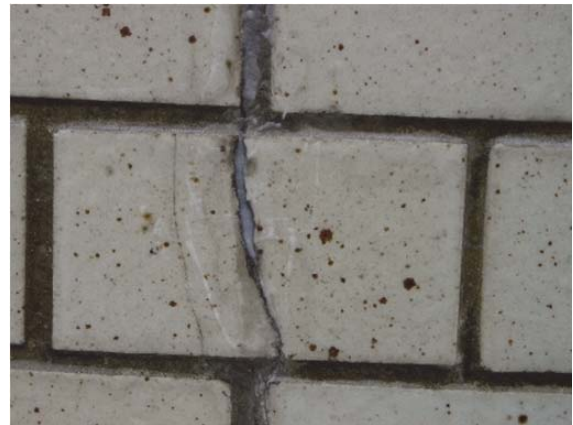
写真6 割れ部のCS-200 [中塗用] による処理
