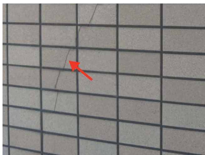
写真 25 改修後 3 年 10 か月経過後のタイル割れ箇所の状況 ・割れと浮きの進行なし ・塗膜異常なし
