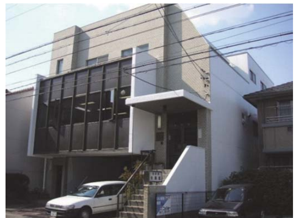
写真8 工事完了時の様子
