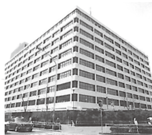
アクリルゴム外壁用塗膜防水材が大規模物件で採用（旧都庁第2本庁舎）
