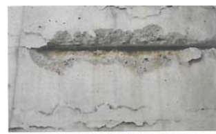
鉄筋の腐食による表層コンクリートの剥離 (東京工業大学 すすかけ台キャンパス内建物)
