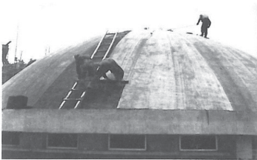
昭和 38 年 警察庁舎 新築シート防水工事
