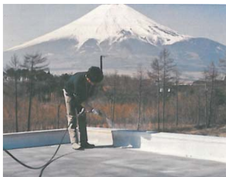
1971年(昭和46) 富士学園屋上SA施工中
