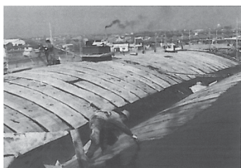
昭和 30 年代 ドーム屋根への防水施工
