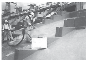
超速硬化ウレタンのスプレー施工
