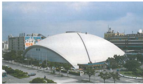
アロンコートSA施工物件 東京国際貿易センター東館（東京都）
