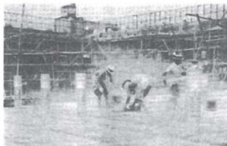
昭和 5 年頃の防水工事
