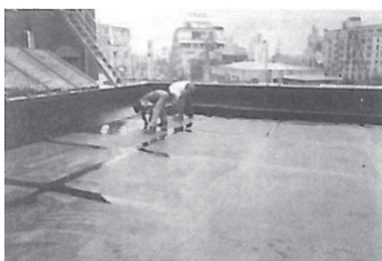
初期ウレタンの防水施工の一例 (ウレタンの塗布量は 2 kg/m²)
