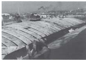
ドーム屋根への防水施工 (アスファルト防水) 昭和 30 年代
