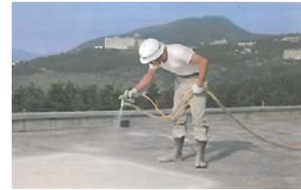
屋上吹付施工中
