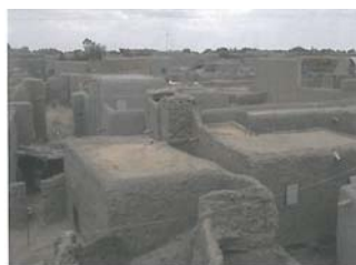
日干しレンガ造の崩壊 マリ共和国 ジェネ 田中享二撮影
