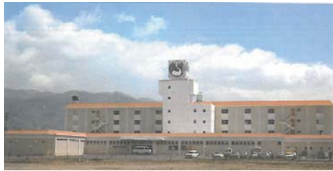
アロンコート施工写真：諏訪湖プリンスホテル
