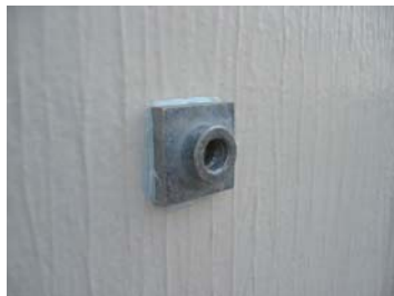
アタッチメントの取付け
