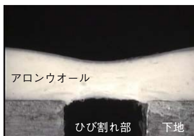
写真2 アロンウオールのひび割れ部での追従状態
