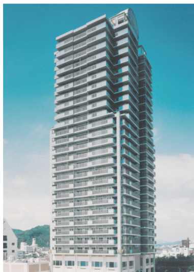
▲鉄筋コンクリート造 外壁化粧防水 「アロンウオール」改修
