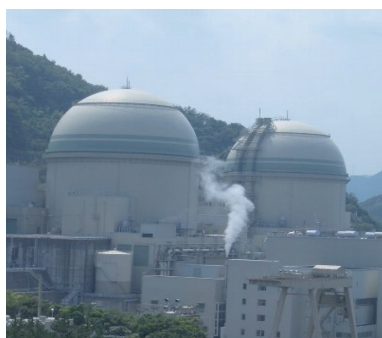
▲原子力発電所建屋
