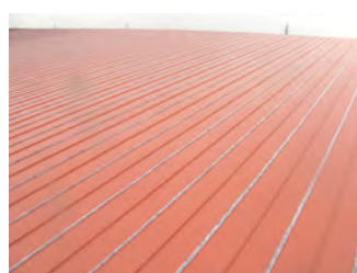
はぜ部 アロンゴムシートテープ貼り
