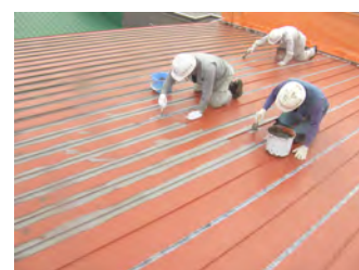
はぜ部 アロンQD-H補強塗り
