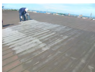
アロンQD-H 2回目塗布状況
