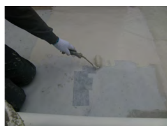
補強布貼付状況
