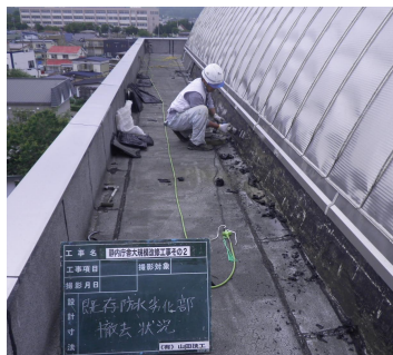
既存防水不良部撤去
