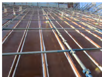
プライマー完了
