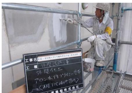
2) アロンウォール NEO 工法 アロン水性プライマー塗布 (下地補修部分)
