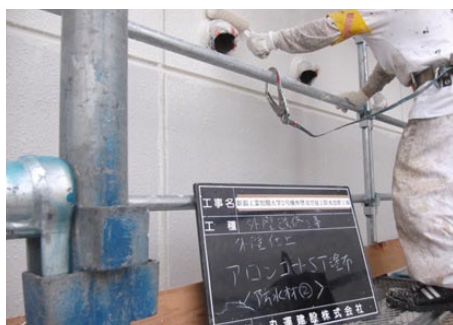
5) アロンウォール NEO 工法 アロンコート ST 塗布 (防水材)
