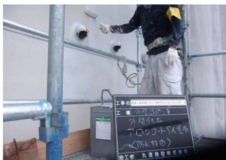
4) アロンウォール NEO 工法 アロンコート SX 塗布 (防水材)
