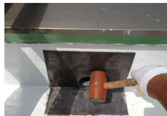
改修用ドレン設置
