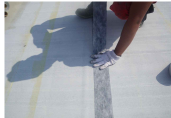
ゴムシートジョイント補強
