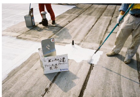
水性プライマー塗布
