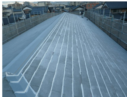
瓦取合シーリング処理
