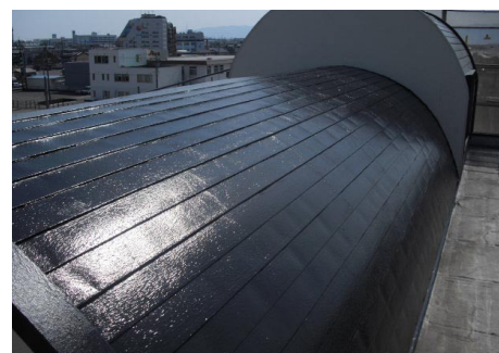
屋根施工完了
