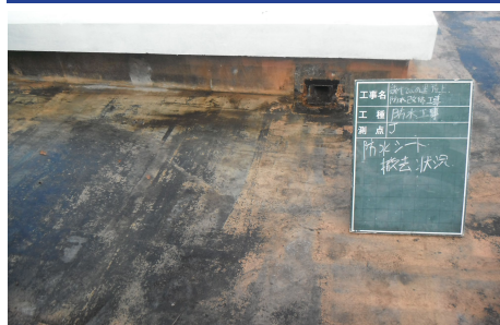
既存ゴムシート撤去完了
