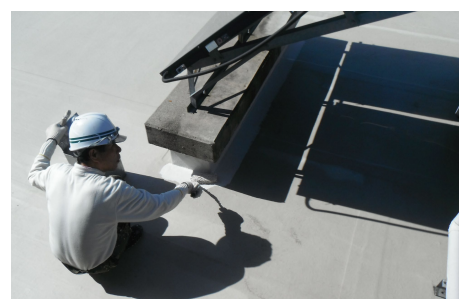
アロン水性RU塗布状況
