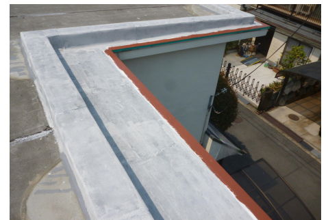
シルバー残存部に水性プライマー塗布、アルミアングルに防錆プライマー塗布
