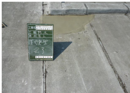
樹脂モルタル補修完了
