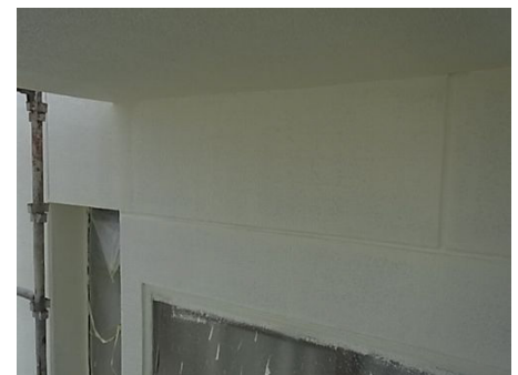
アロンコート ST 塗布完了
