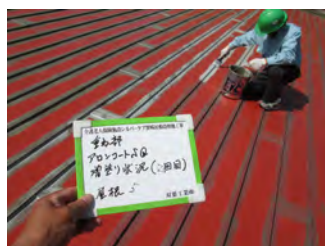
段差部アロンコートSQ増塗状況
