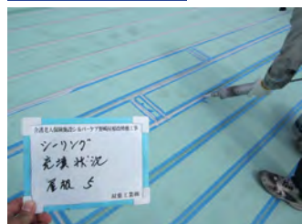
段差シーリング処理
