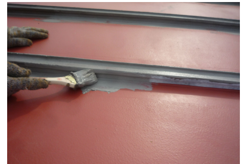
瓦棒増し塗状況
