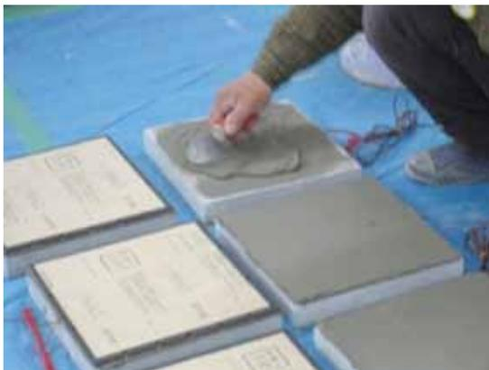
写真2 張付けモルタルの塗布状況
