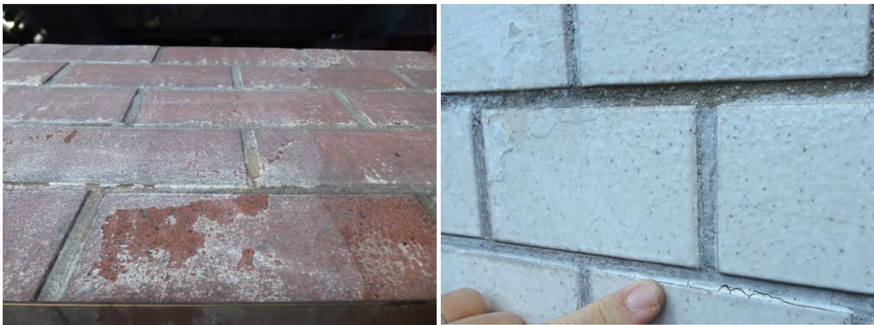
写真1 他社工法の経年による硬質化および割れ
