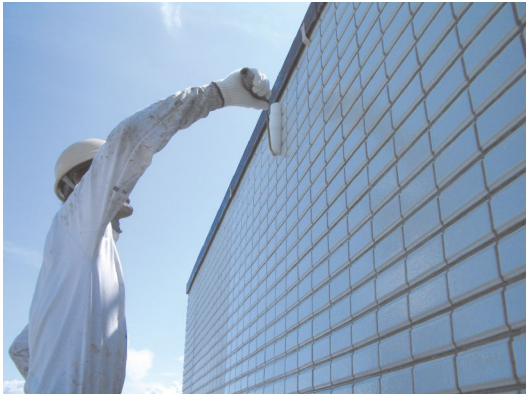
写真 5 クリアウオール施工時の様子
