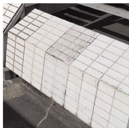
写真 4 屋上暴露の様子
