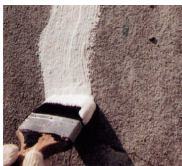
写真2 下地挙動緩衝材の施工
