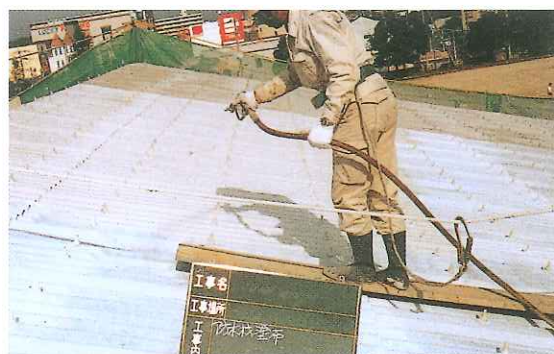
中塗材吹付け
