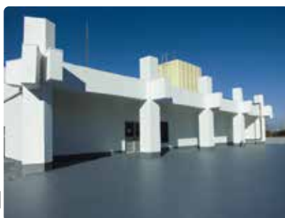
◀ 某大学屋上ペイントハウス(愛知県) ▼
