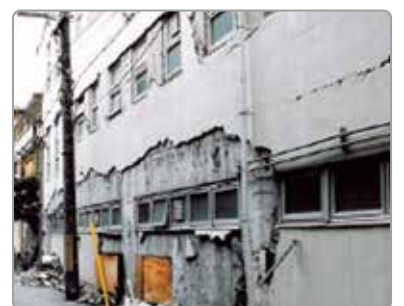
一般的な外壁の状況
