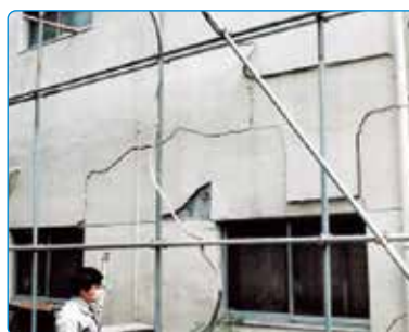
アロンウオール塗布外壁の状況
