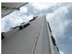
同上・壁面の外観 (非常に綺麗)
