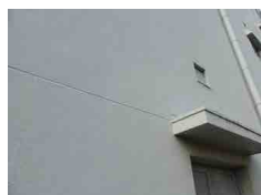
同上・出隅・役物周りの外観 (非常に綺麗)
