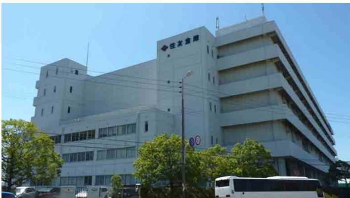
大阪南港（1998年7月施工、2016年9月撮影）
