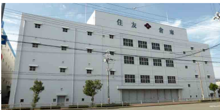
大阪安治川（2006年3月施工 2016年9月撮影）
