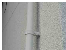
同上・縦樋金物周りの外観 (非常に綺麗)
